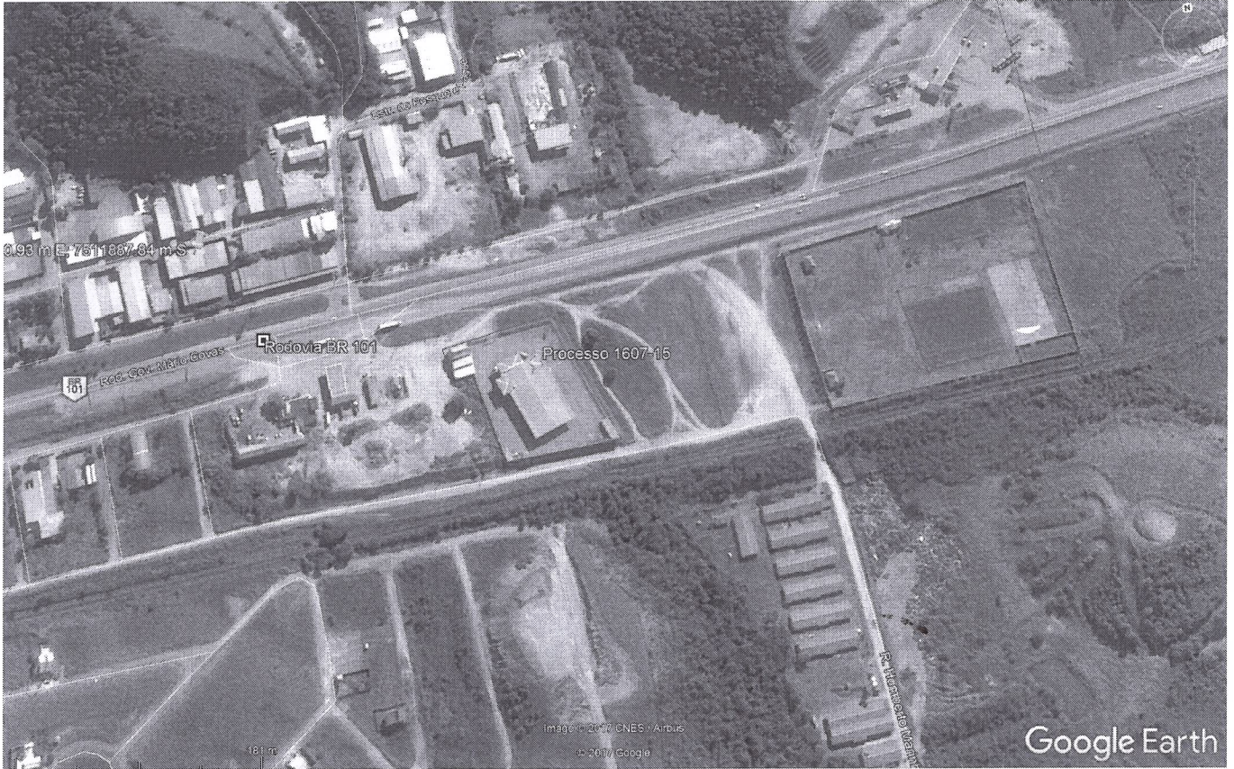
Figura 1: Imagem aérea do empreendimento
