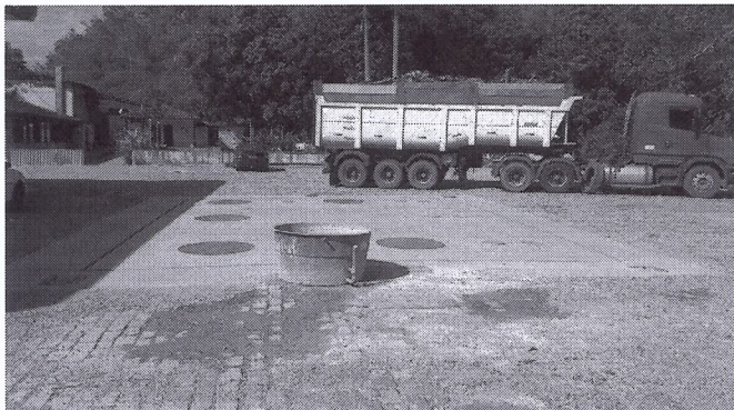
c) Tanques subterrâneos
