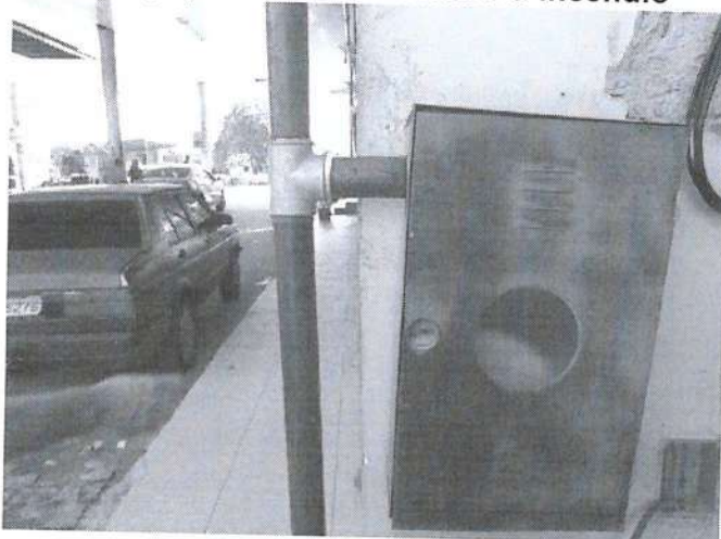
m) equipamento de combate a incêndio
