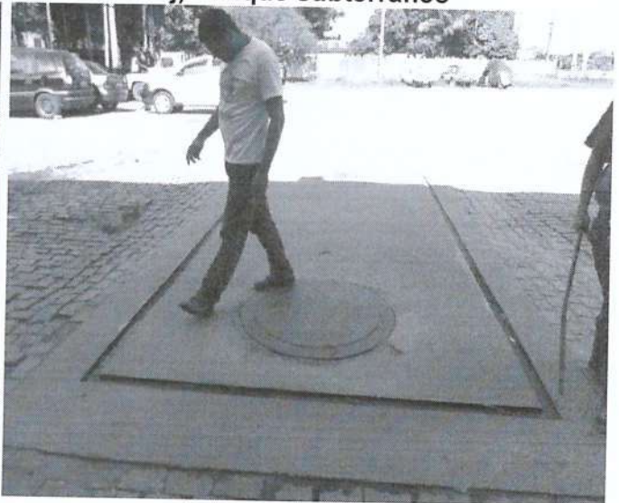
l) Poço de vistoria
