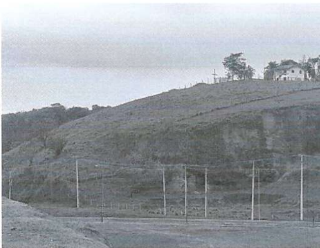
Vista da área a ser implantada a via com a ETA no topo.
