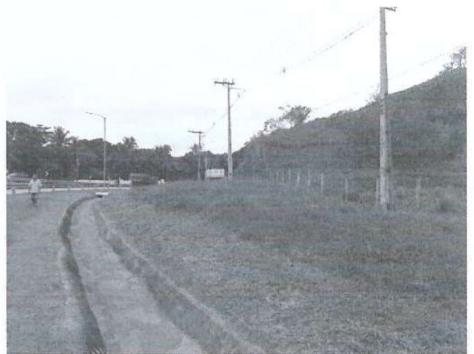
Vista do futuro acesso e rede de drenagem da rodovia.
