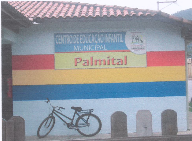
Fachada principal da Creche já em funcionamento
