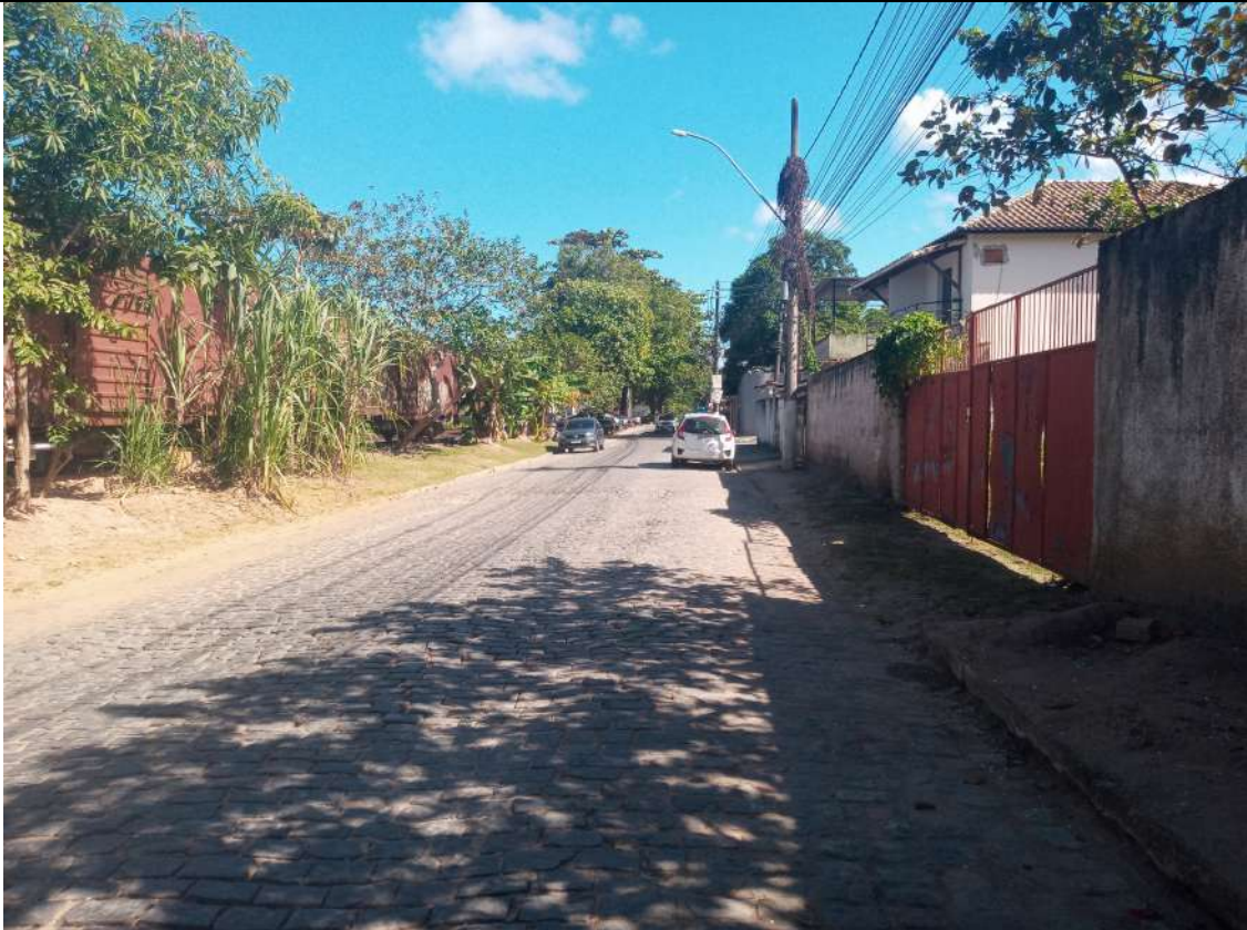
FIGURA 22: Vista do local de Implantação da linha de distribuição de energia elétrica, às margens da Linha Férrea e Rua Humberto Marinho.
