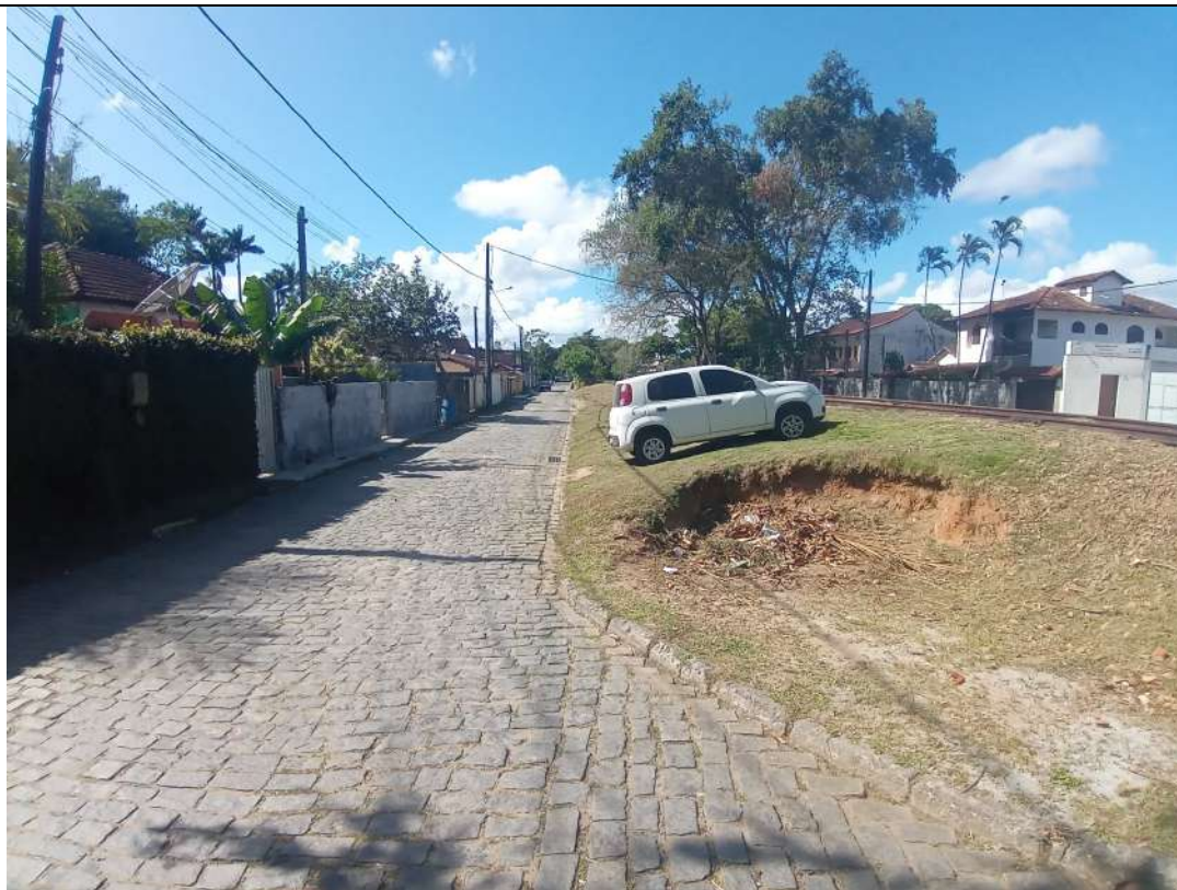
FIGURA 30: Vista do ponto final da Implantação da linha de distribuição de energia elétrica, às margens da Linha Férrea na Rua Humberto Marinho.
