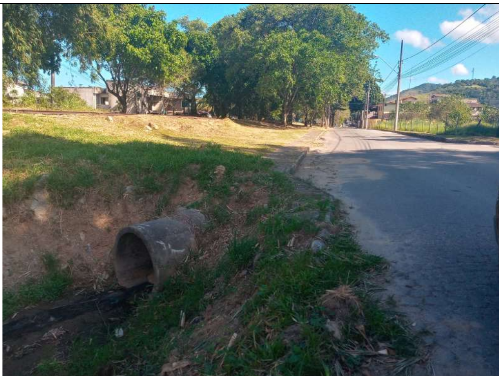
FIGURA 12: Canal de Drenagem próximo ao local de implantação da linha de distribuição de energia elétrica, às margens da Rua Humberto Marinho.
