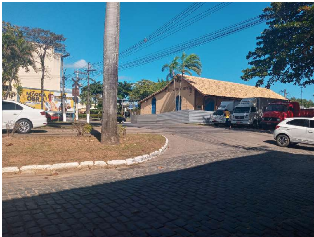
FIGURA 24: Vista do local de Implantação da linha de distribuição de energia elétrica, às margens da Linha Férrea na Rua Humberto Marinho com a Rua Leoncio Capivari.
