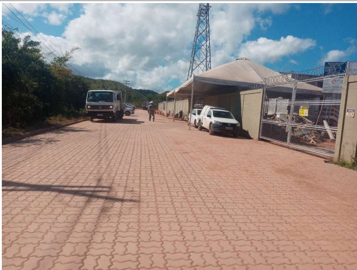
FIGURA 4: Entrada da Subestação.
