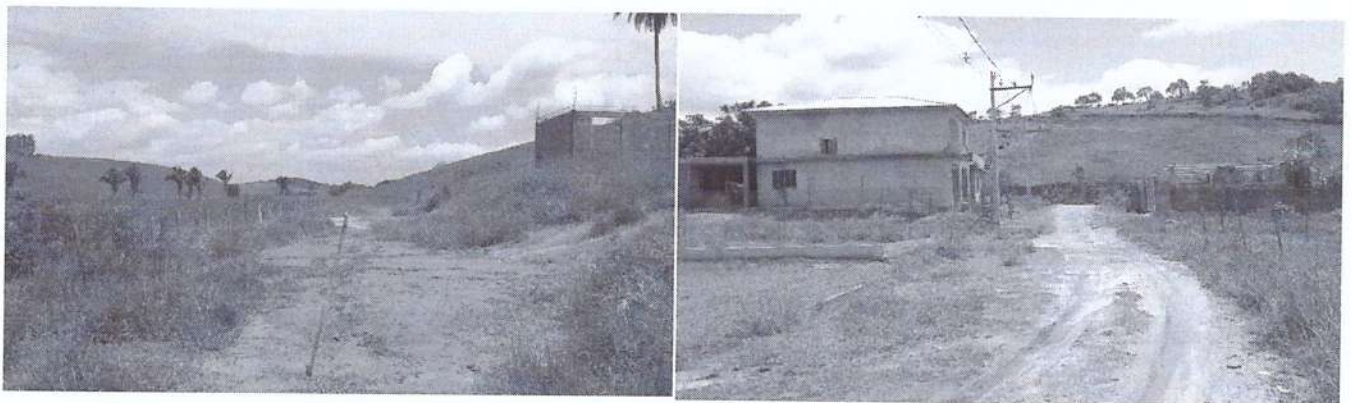
FIGURA 2: Imagens da vistoria Rua dos Eucalipto e Dos trevos.
