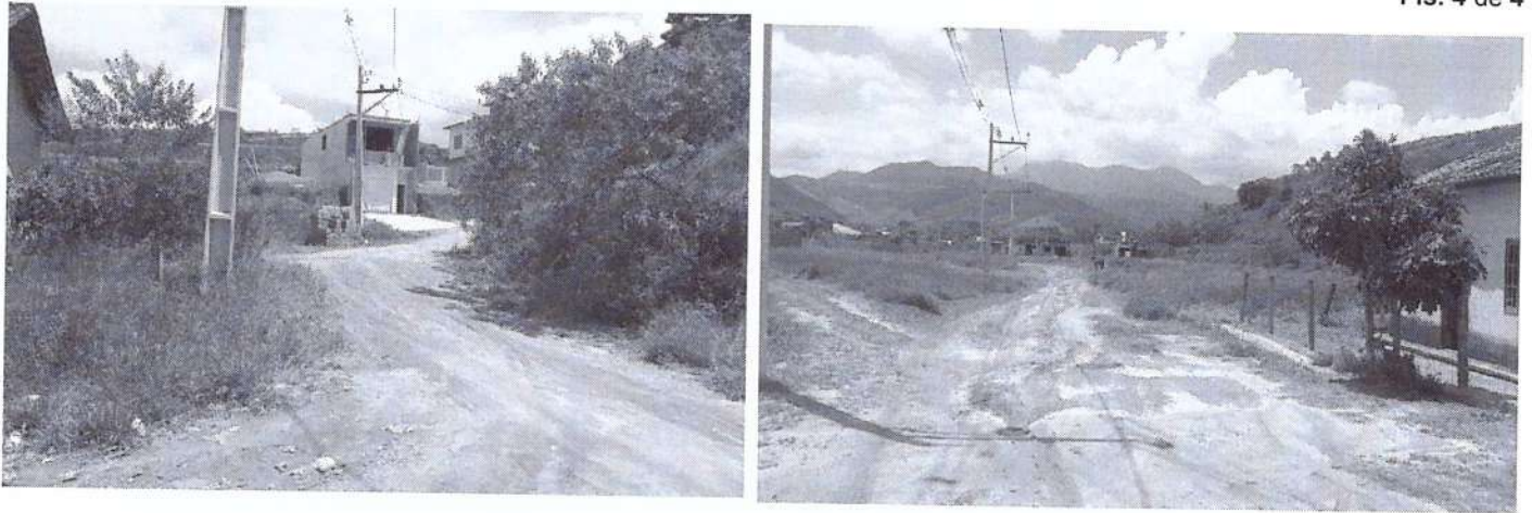
FIGURA 3: Imagens da vistoria Rua das Flores.
