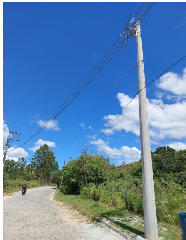
(B) Visão inicial da implantação da extensão de rede
