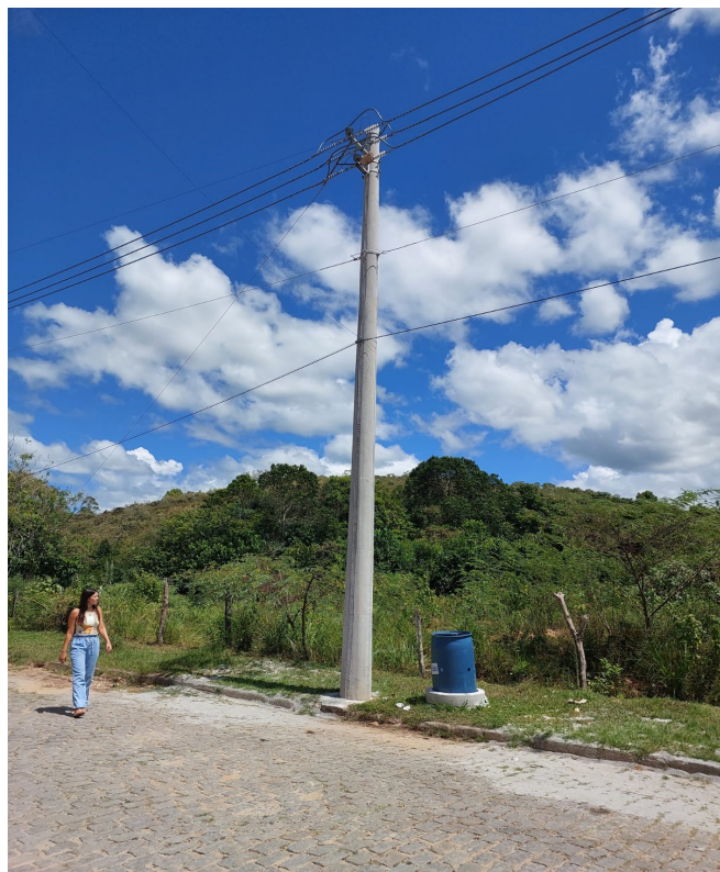
(A) Vista do poste inicial onde será puxado a extensão de rede
