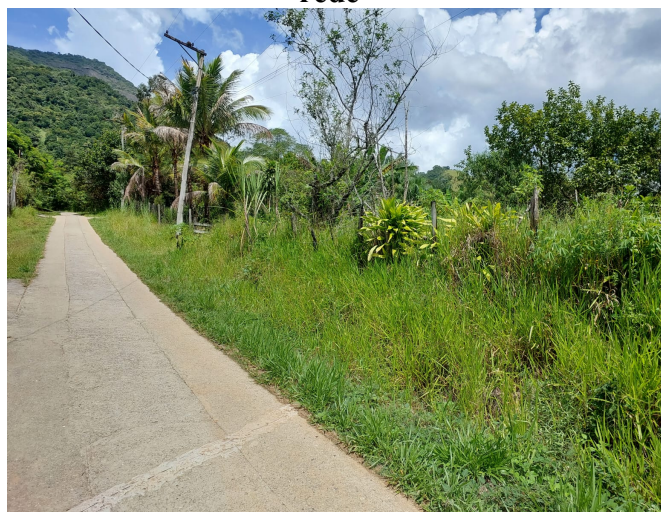
(B) Vista da área que receberá a extensão de rede
