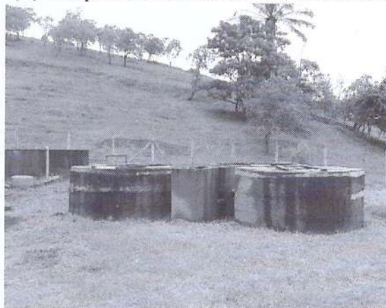
(D) Tanques de Decantação de Lodo
