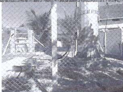
(B) Base da torre
