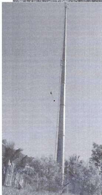
(D) Vista da torre.
