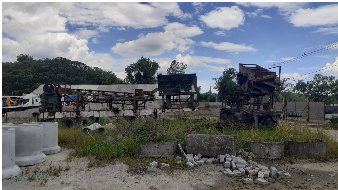
FIGURA 4: Registro fotográfico da máquina de triturar resíduos de construção.
