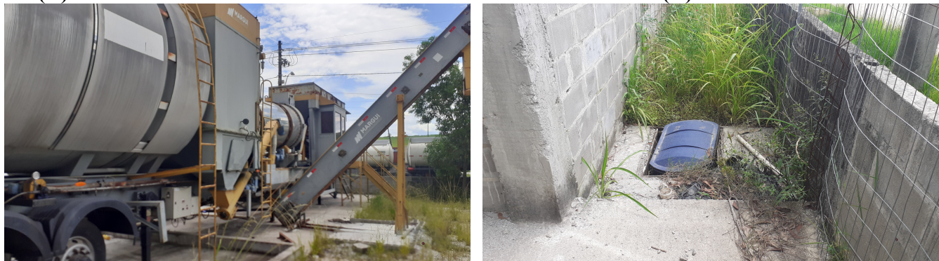
FIGURA 4: Registro fotográfico da usina de asfalto.
