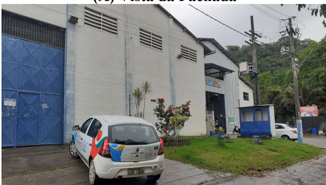
(A) Vista da Fachada
