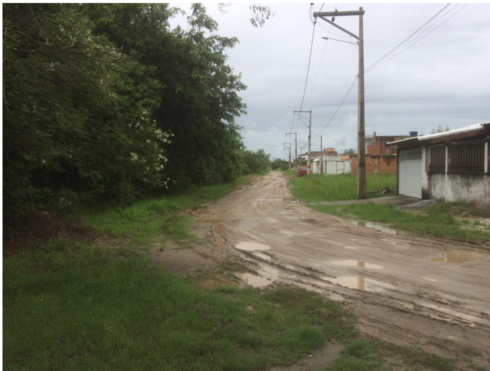
Imagem 05: Rua E no Loteamento Recanto dos Paratis II / Coordenada UTM: 24 K 192674.13 m E 7502525.51 m S
