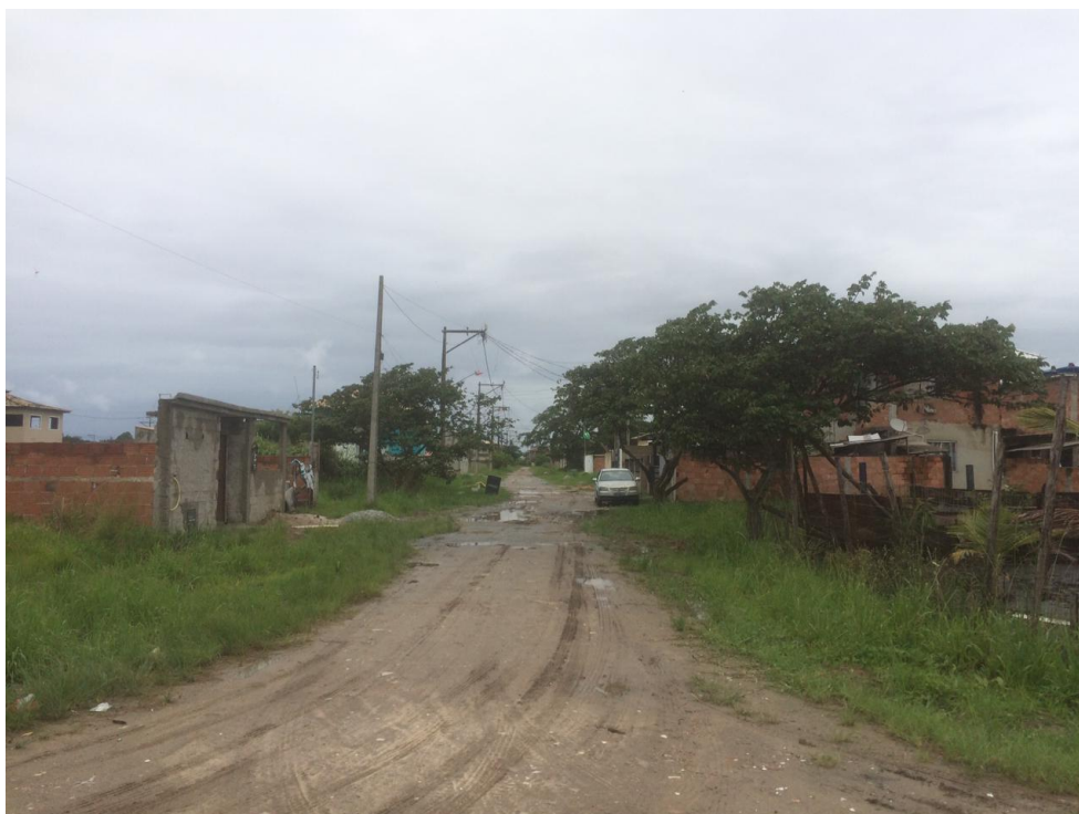
Imagem 08: Rua H no Loteamento Recanto dos Paratis II / Coordenada UTM: 24 K 192526.81 m E 7502598.61 m S
