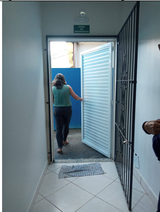
Imagem 27: Passagem para área lateral externa.
