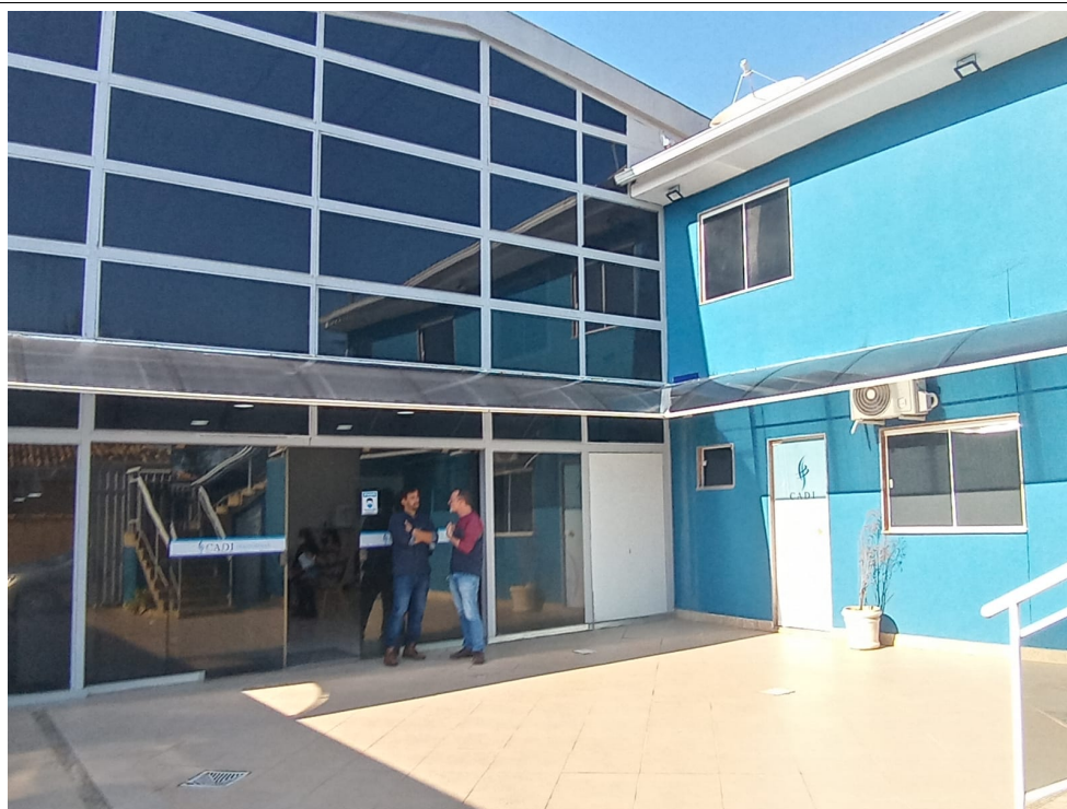
Imagem 3: Entrada do empreendimento.
