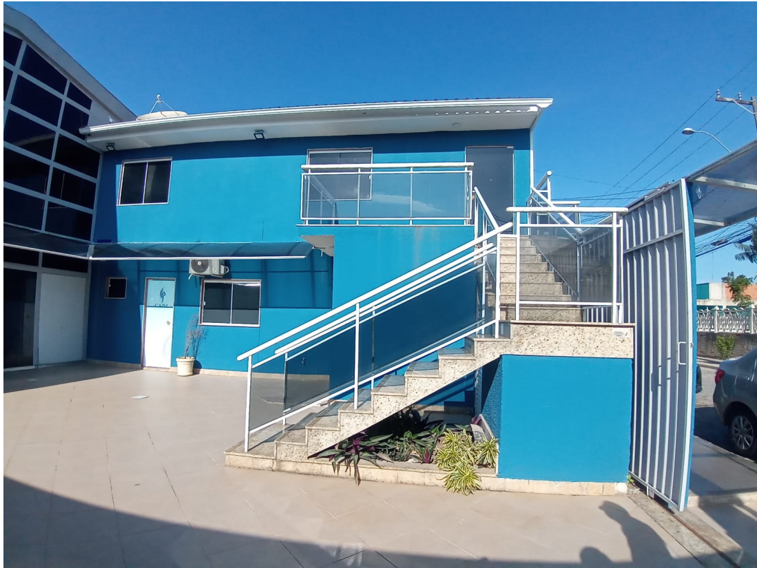
Imagem 4: Entrada da área administrativa do empreendimento.
