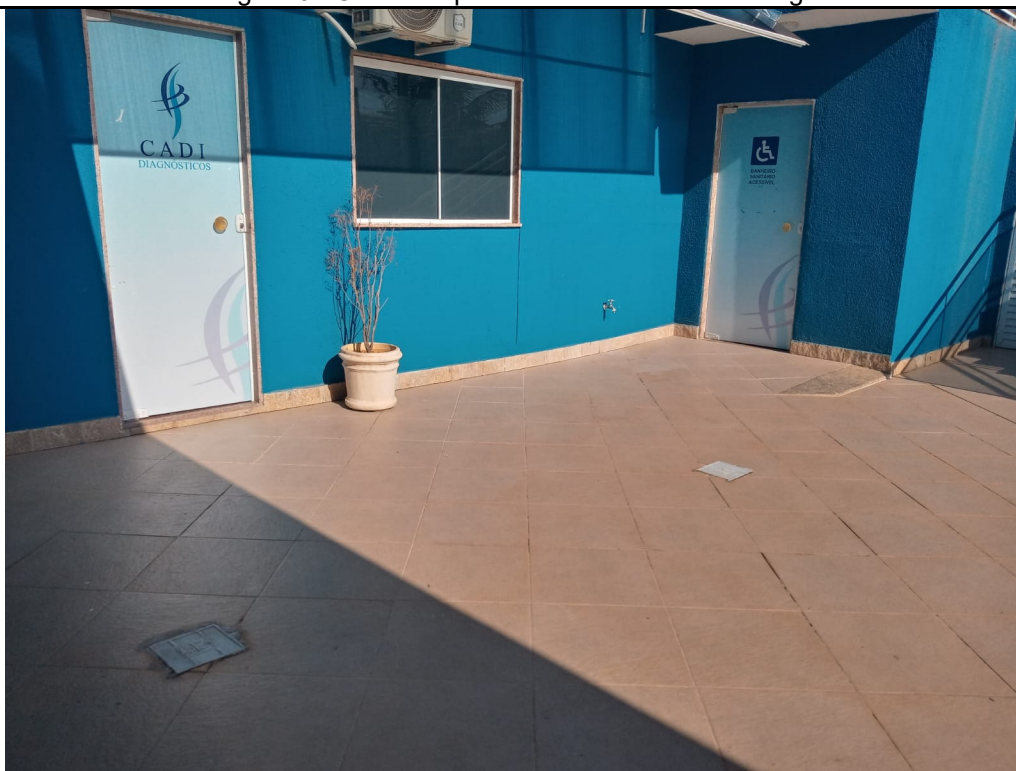
Imagem 7: Caixa de Inspeção - Fossa Séptica e Filtro.
