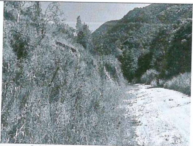
Imagem 3: Vista frontal da via de acesso existente
