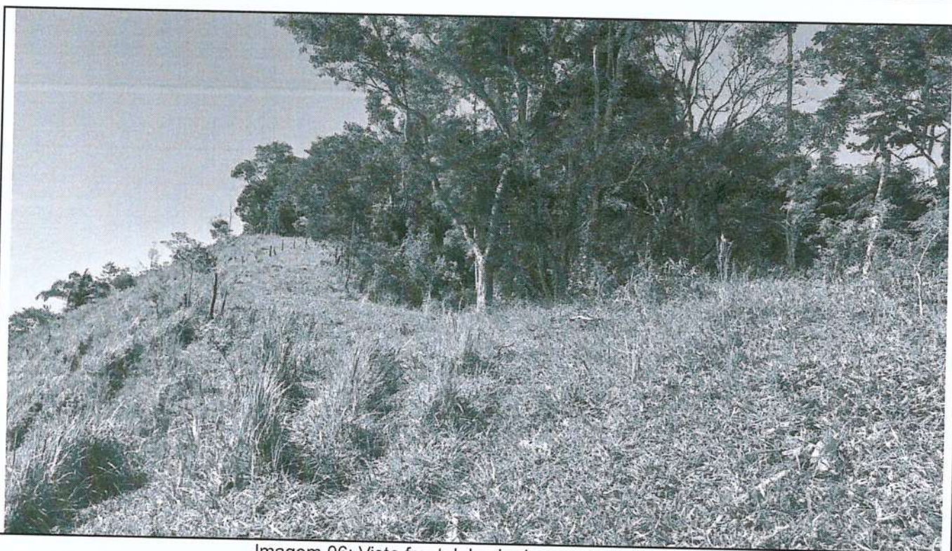
Imagem 06: Vista frontal da via de acesso existente.
