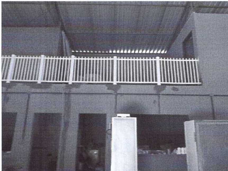
Imagem 10: Intervenção no interior do imóvel.
