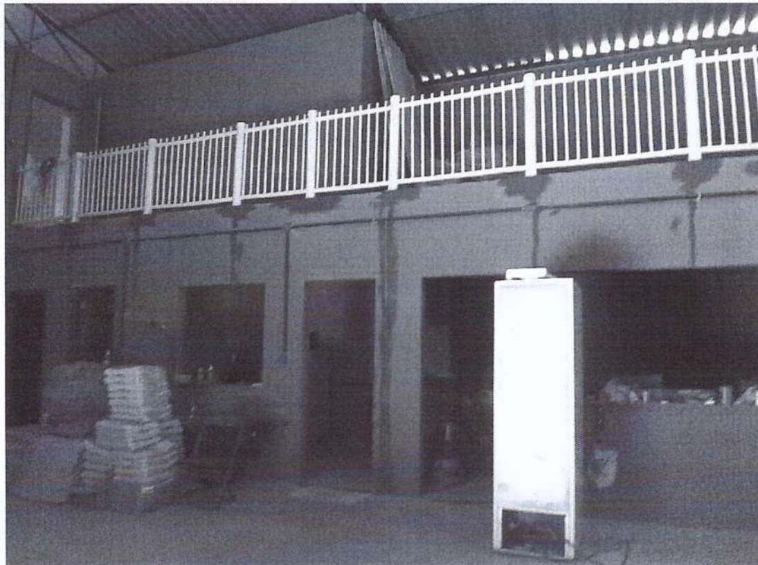
Imagem 6: Área ainda em construção/reforma.
