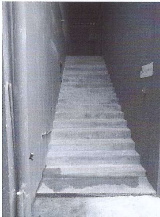
Imagem 9: Escada de acesso ao 2º (segundo) pavimento.
