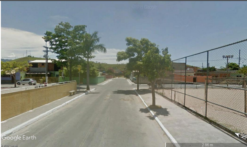
Imagem 7: Rua Alcebiadina Demier Brust (coordenadas UTM 23K 788339.71 m E 7509694.75 m S).
