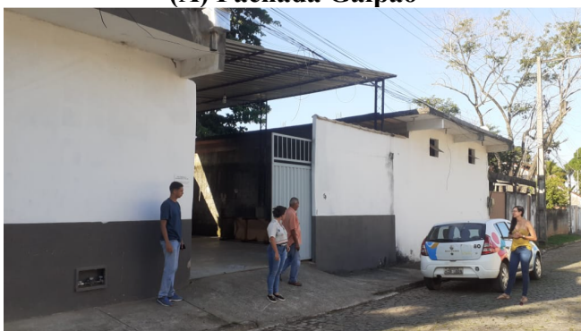
(A) Fachada Galpão
