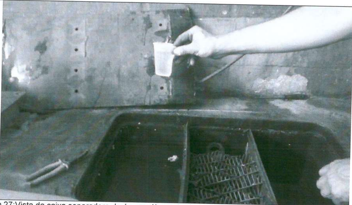
Imagem 27: Vista da caixa separadora de água e óleo entrada e saída com água limpa para a rede de coleta de esgoto.
