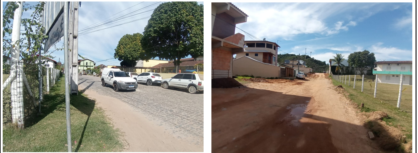
Imagem 3: Rua transversal a Rua Prefeito José Bicudo Jardim
