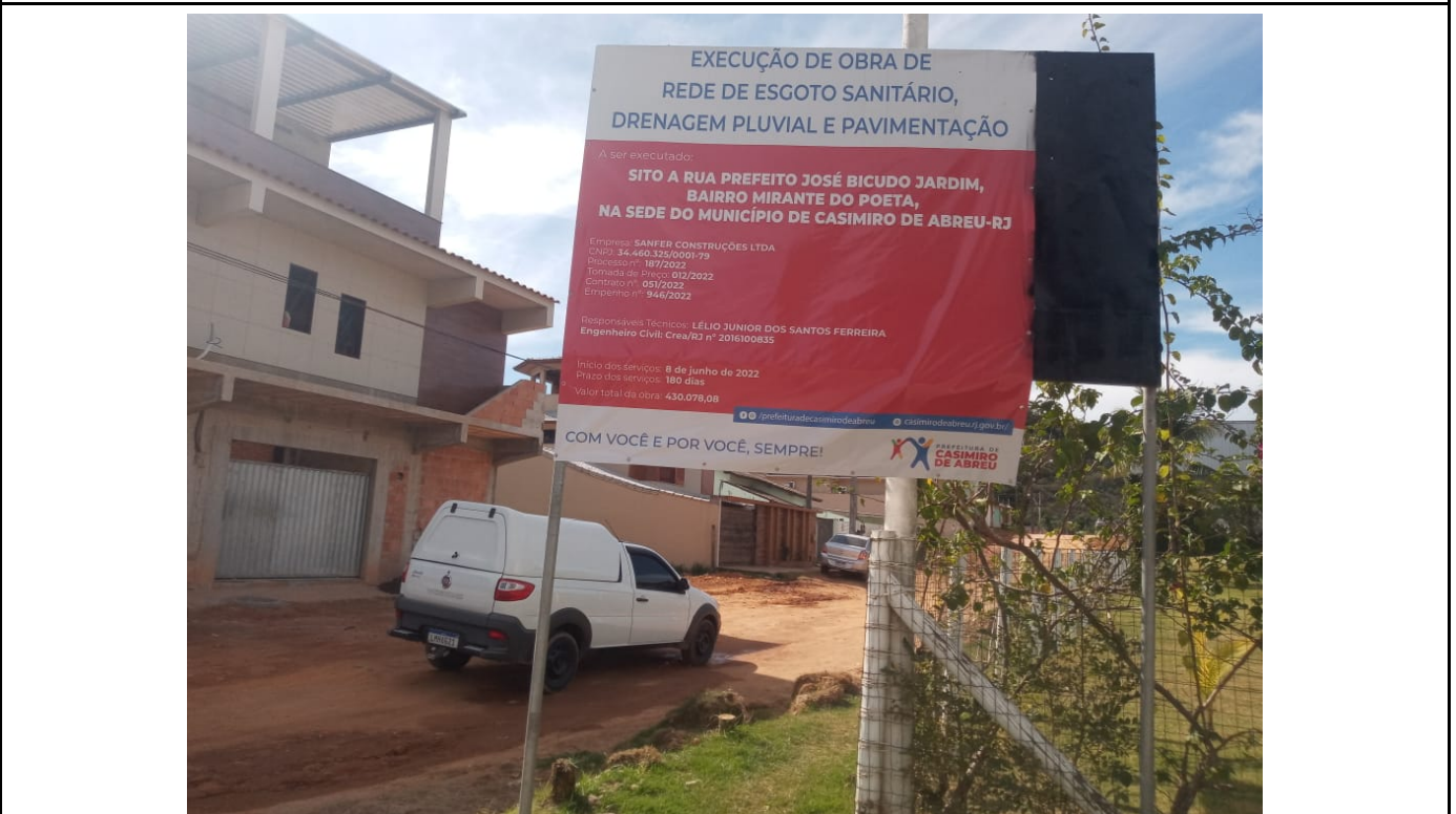
Imagem 4: Placa sinalizando a obra
