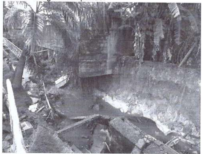
Foto 4: Margem solapando.
