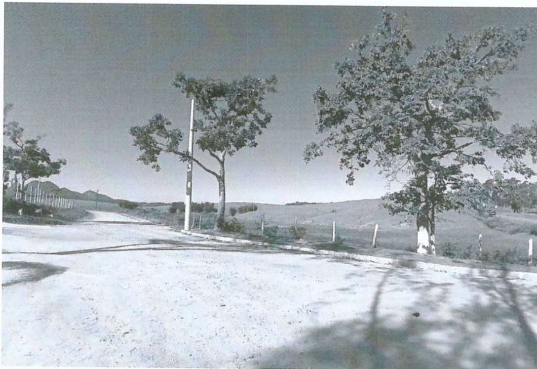
Imagem 02: Postes para implantação da rede de distribuição de energia elétrica.
