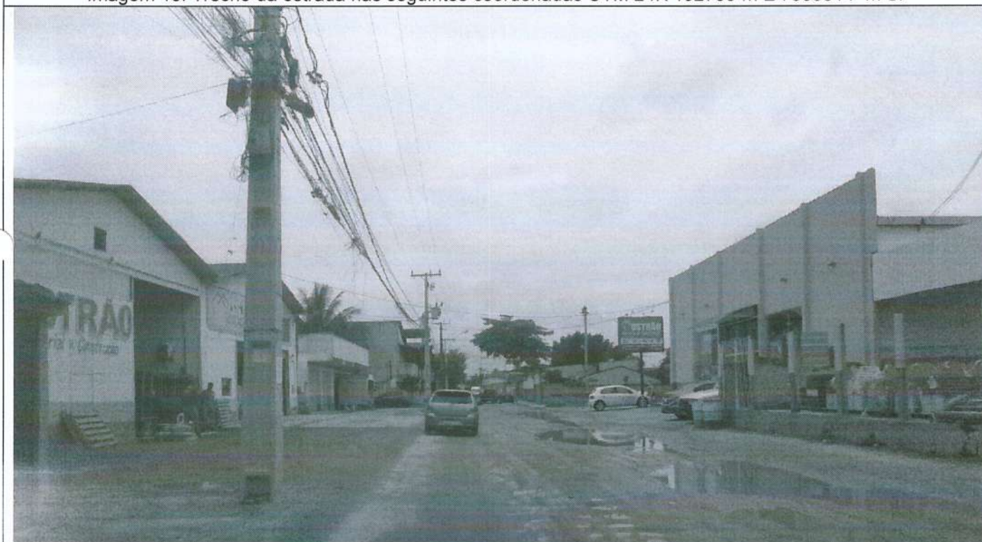
Imagem 16: Trecho da estrada nas seguintes coordenadas UTM 24K 192910 m E 7503524 m S.
