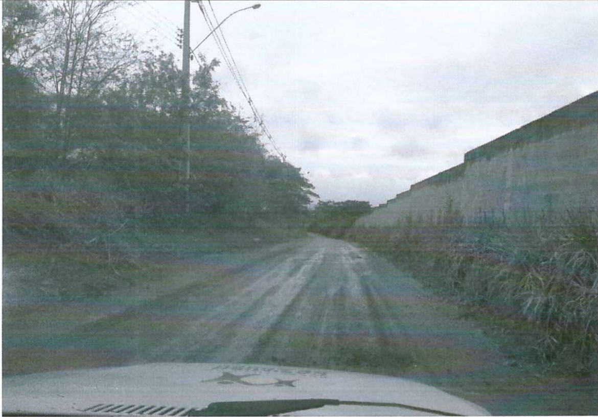
Imagem 27: Trecho da estrada nas seguintes coordenadas UTM 24K 192292 m E 7507550N m S
