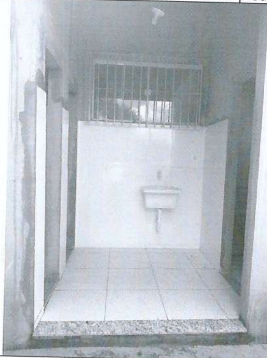
Imagem 11: Foto da área externa, acesso aos banheiros e vestiário.
