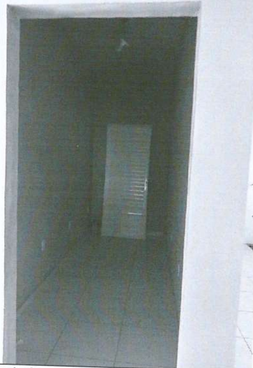
Imagem 9: Foto do local onde futuramente será instalado um Câmara de Refrigeração.
