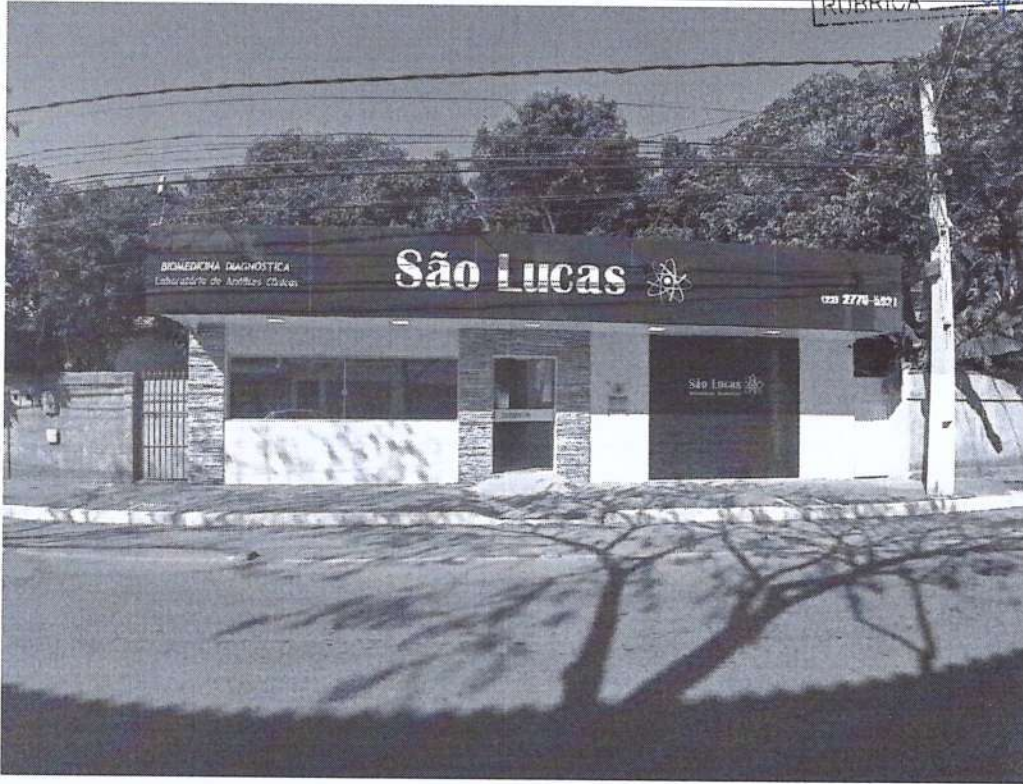
Imagem 2: Fachada do empreendimento
