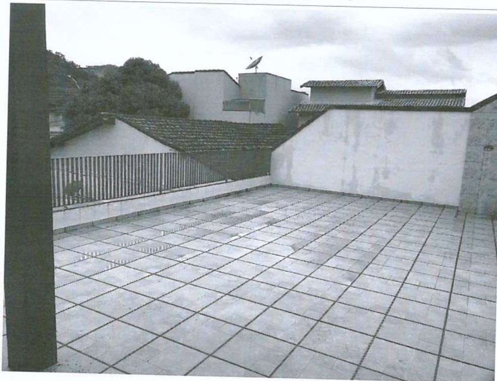
Imagem 06: Área externa, ao lado do escritório
