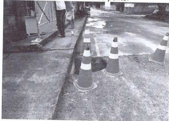
Foto 2: Vista da cabeceira da ponte.
