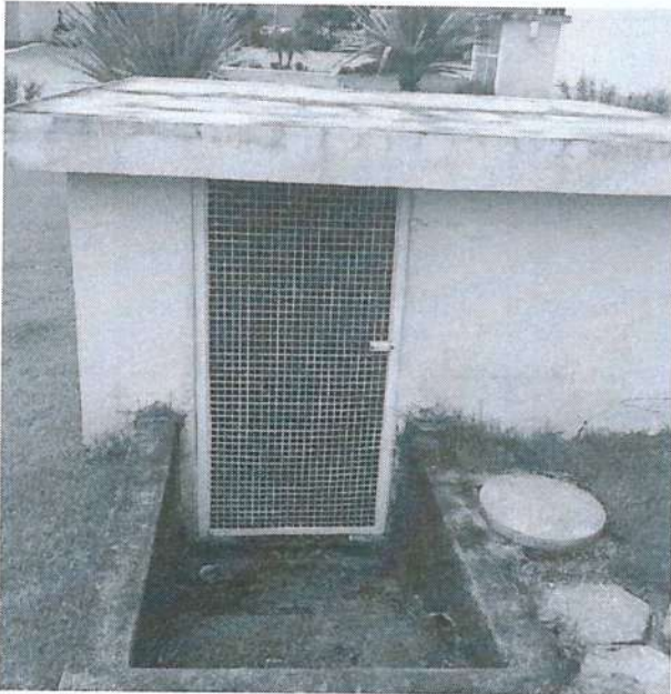
Figura 8: Construção de alvenaria que abriga poço artesiano.
