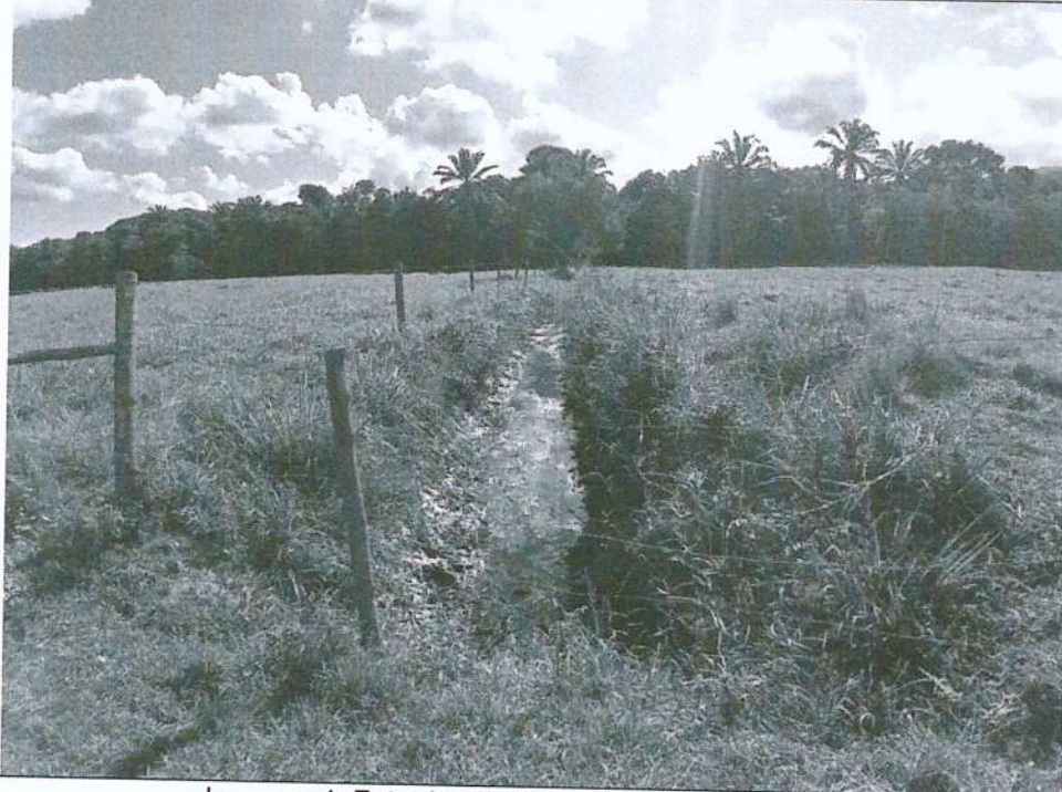
Imagem 4: Foto do Ponto 2 - Canal de Drenagem
