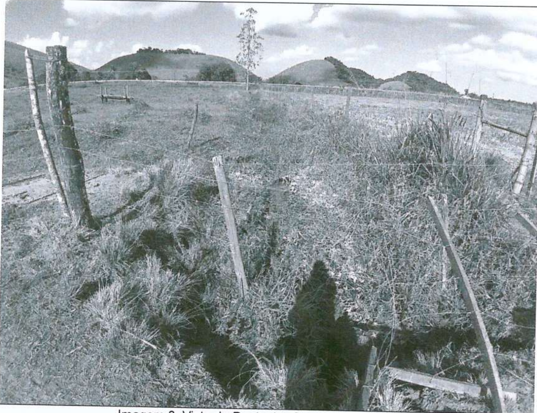
Imagem 3: Vista do Ponto 1 – Canal de Drenagem.
