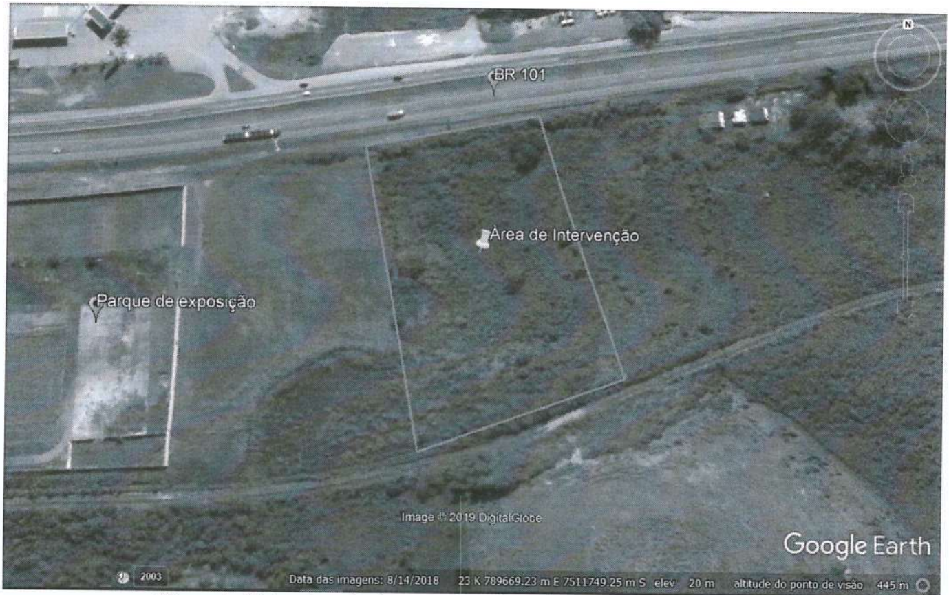
Figura 1: Vista aérea da área a ser Implantada a subestação de energia.
