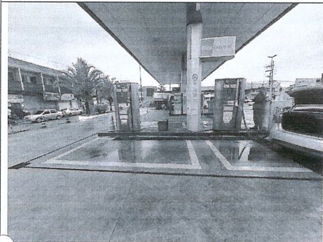
Imagem 06: Pista de abastecimento com piso impermeável e canaletas ao redor
