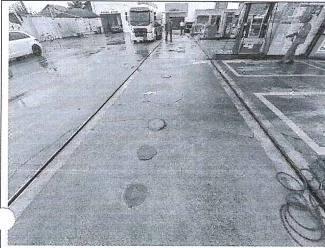
Imagem 11: Área de tancagem de combustível
