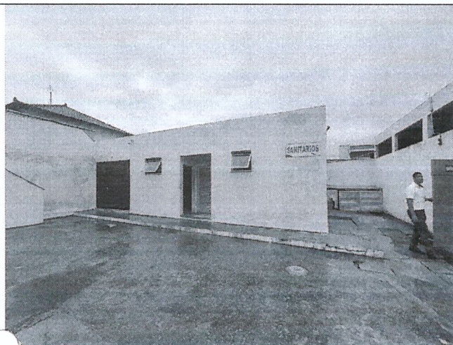
Imagem 19: Prédio auxiliar - Sanitários
