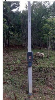
(B) Padrão instalado
