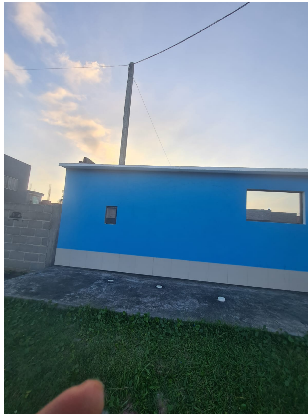
Figura 2: Localização da propriedade (FACHADA)
