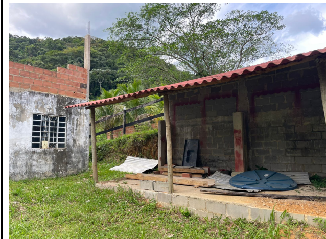
Foto 04: Varanda em construção
