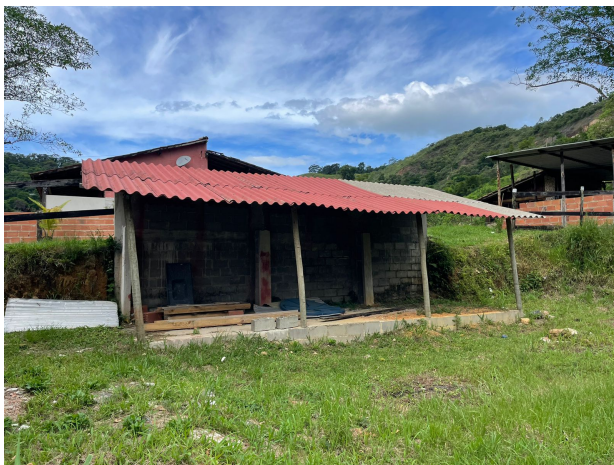
Foto 05: Varanda em construção
