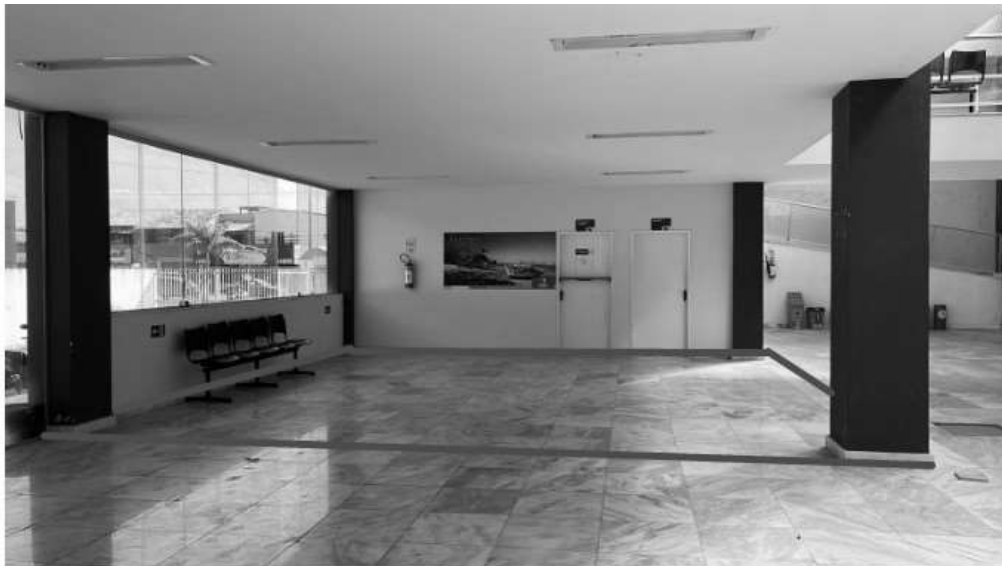
Foto 2 -Area de ampliação em divisória – Sec. Fazenda
