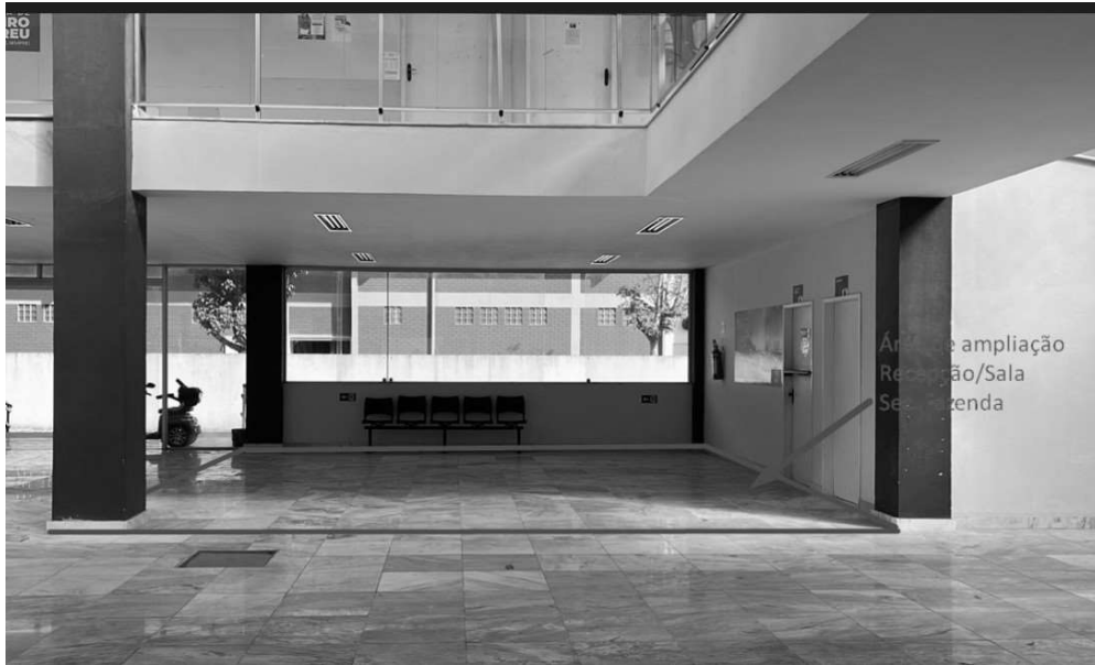
Foto 1 -Area de ampliação em divisória – Sec. Fazenda
