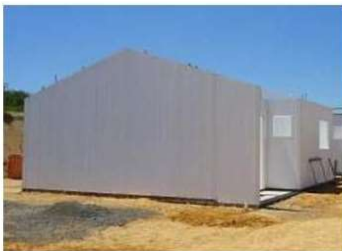
Figura 14 – Painéis de PVC concretados
