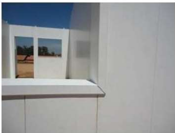
Figura 15 – Abertura das janelas com acabamentos em PVC
