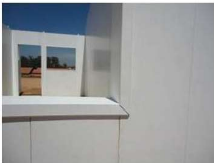
FIGURA 26 – Abertura das janelas com acabamentos em PVC
