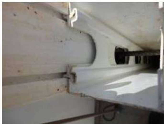
Figura 12 – Ferragem posicionada na região da contra-verga
