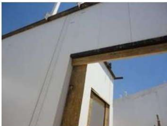
FIGURA 24 – Escoramento de aberturas de portas para concretagem
