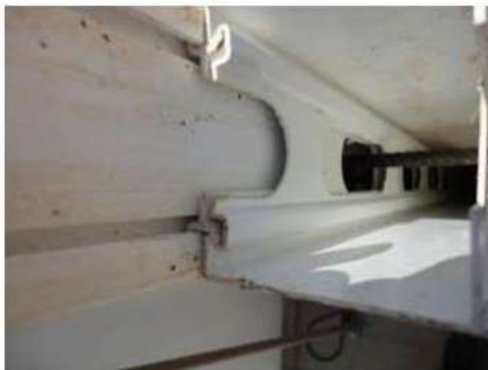
FIGURA 23 – Ferragem posicionada na região da contra-verga
