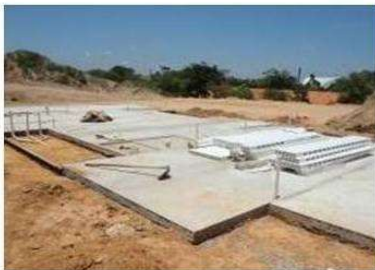
FIGURA 19 – Elemento de fundação com planicidade adequada
