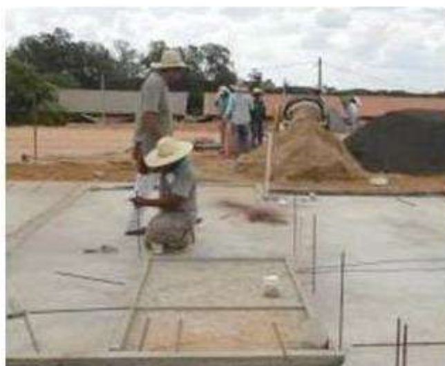
Figura 9 – Fixação das barras de ancoragem à fundação com adesivo epóxi
