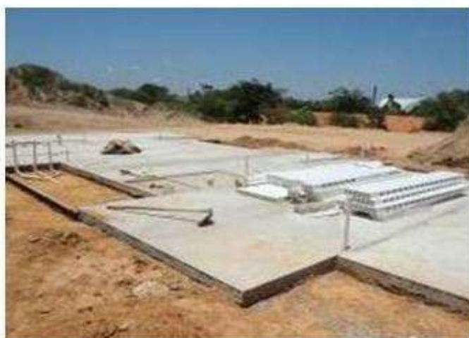
Figura 8 – Elemento de fundação com planicidade adequada
