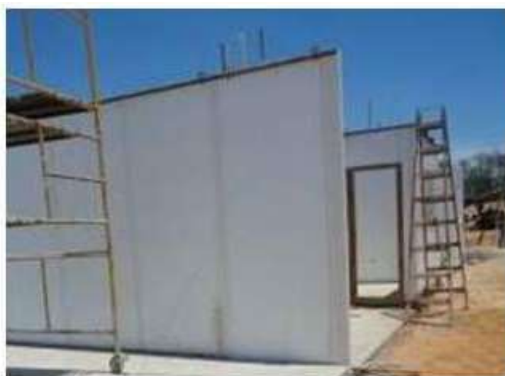
Figura 11 – Painéis de PVC posicionados e escorados
