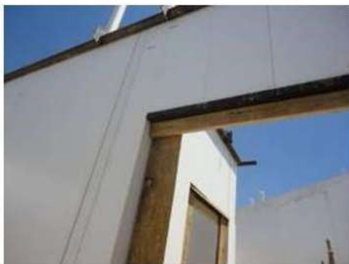
Figura 13 – Escoramento de aberturas de portas para concretagem
